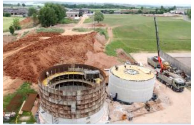
Ein Blick auf die neu entstehende Biogasanlage neben der Milchviehanlage Lauterbach. In das Projekt investiert das Agrarunternehmen Lauenhain etwa 2,3 Millionen Euro.
